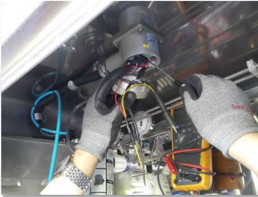
Sensor 정격전압 측정 및 교정
